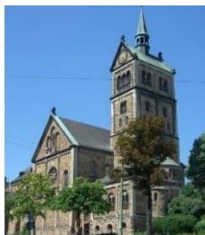
St. Maria Zentrales Pfarrbüro Kirchweg 71, 34119 Kassel
